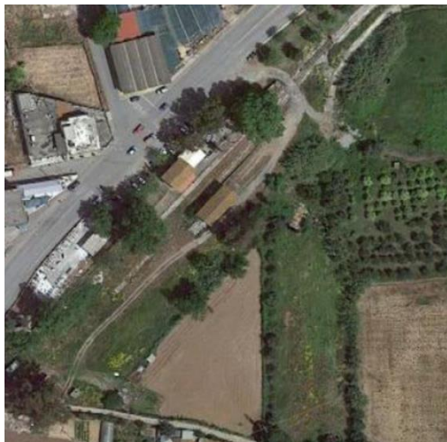
Φωτογραφία 5: Σιδ. Σταθμός Μεσσήνης
