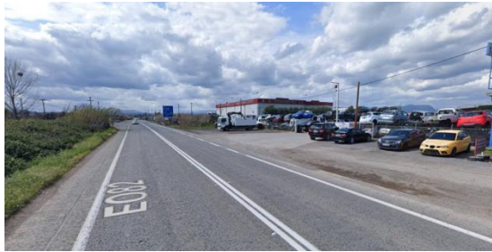
Φωτογραφία 1: Υφιστάμενη κατάσταση στον οδικό άξονα Μεσσήνη - Ασπρόχωμα (παρόδιες ιδιοκτησίες πλησίον της οδού)
