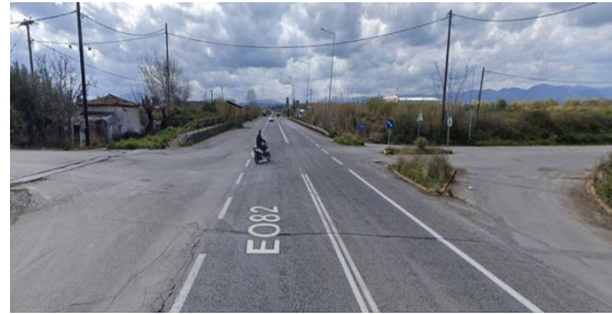
Φωτογραφία 2: Υφιστάμενη κατάσταση στον οδικό άξονα Μεσσήνη - Ασπρόχωμα (διασταυρώσεις επί της οδού)
