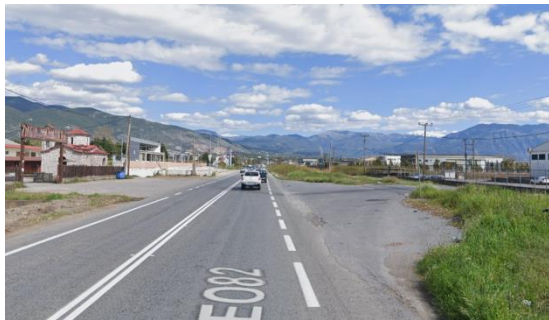
Φωτογραφία 3: Υφιστάμενη κατάσταση στον οδικό άξονα Μεσσήνη - Ασπρόχωμα (παρόδιες ιδιοκτησίες εκατέρωθεν της οδού)
